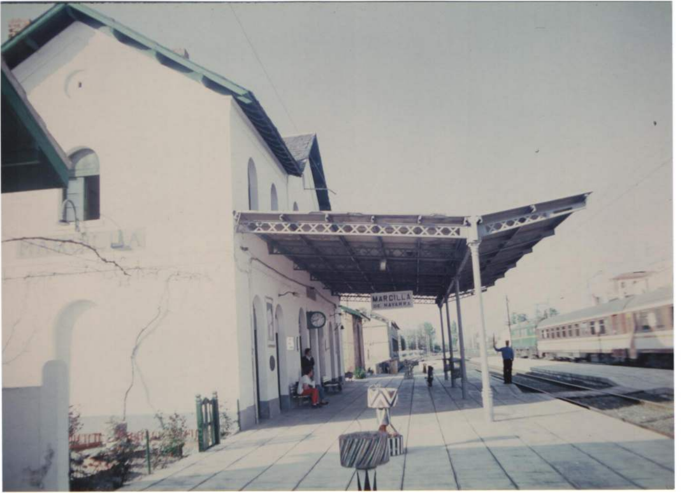
21. Estación del ferrocarril de Marcilla.
